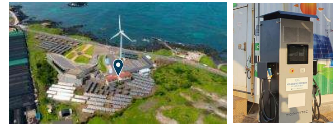
신재생에너지 홍보관 내 설치된 V2G 충전기
